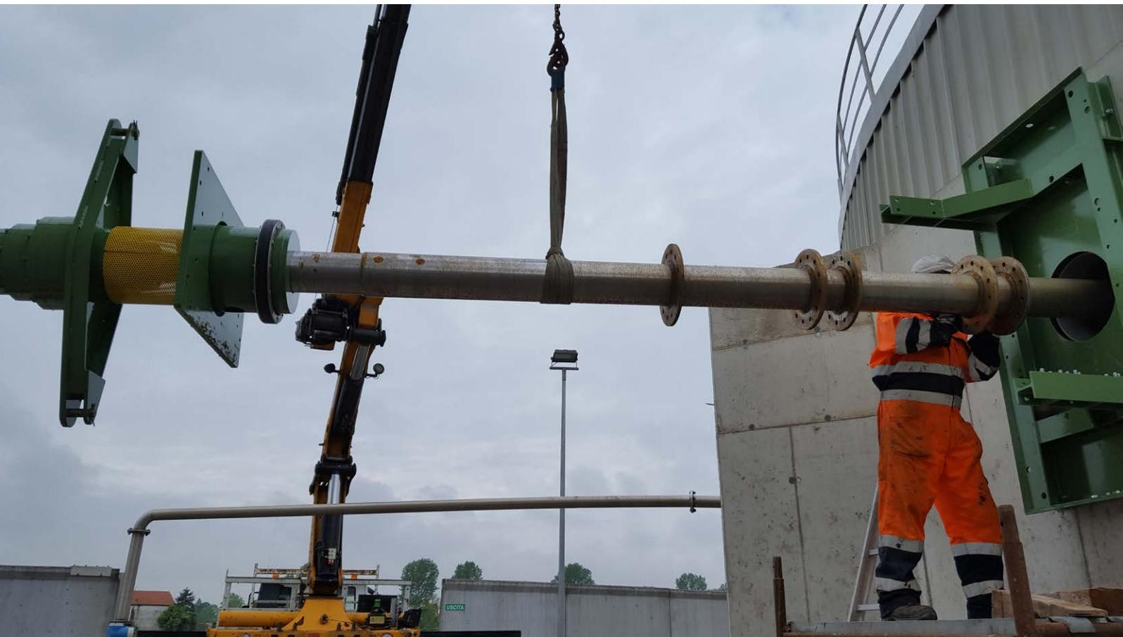
L'innovativo sistema **COMBI** progettato dal team di Corradi & Ghisolfi per la **miselazione dei fermentatori anaerobici**, si distingue dagli altri sistemi di miselazione, per l'**estrema robustezza ed efficienza di miselazione con ridottissimi consumi di energia elettrica**.
